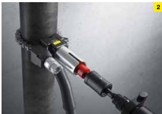
2. Vrtačkou se vyvrtá otvor a vrtací pouzdro se odebere.
