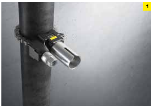
1. Na ocelovou trubku se připevní speciální vrtací pouzdro pro vedení vrtacího vřetena.
