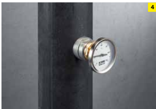
4. Perfektní přípojka v ocelové trubce je nyní hotová - např. pro teploměry, manometry nebo vypuštění.
