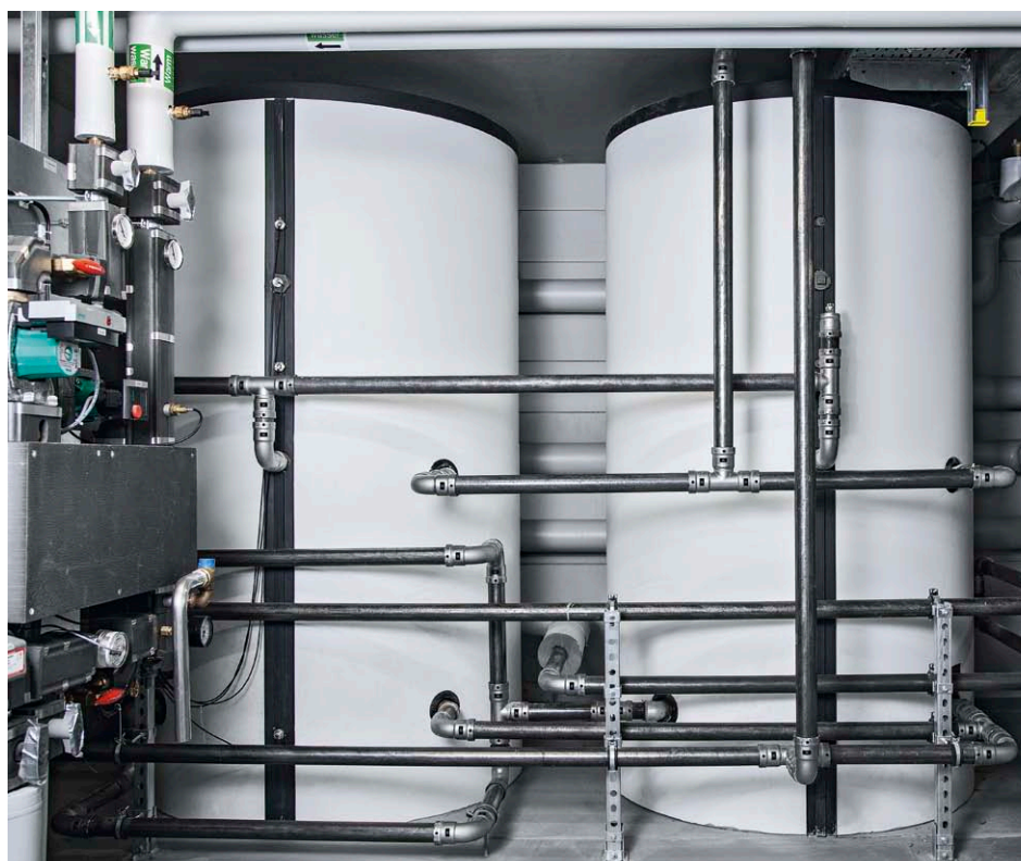
Megapress v topné soustavě s akumulacími nádobami.
