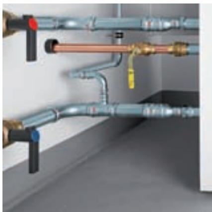
Připojení topných kotlů: Přívod a zpátečka pomocí Prestabo a kulových ventilů Easytop. Přípojka plynu pomocí Profipress G.
