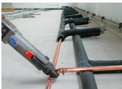
Připojení topných těles bez nebezpečí vzniku požáru.
