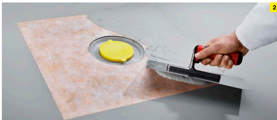
Nanášení 2. vrstvy utěsnění tvořené dvousložkovou směsí plastické hmoty a cementové malty, která je ve stavebnictví osvědčená.
