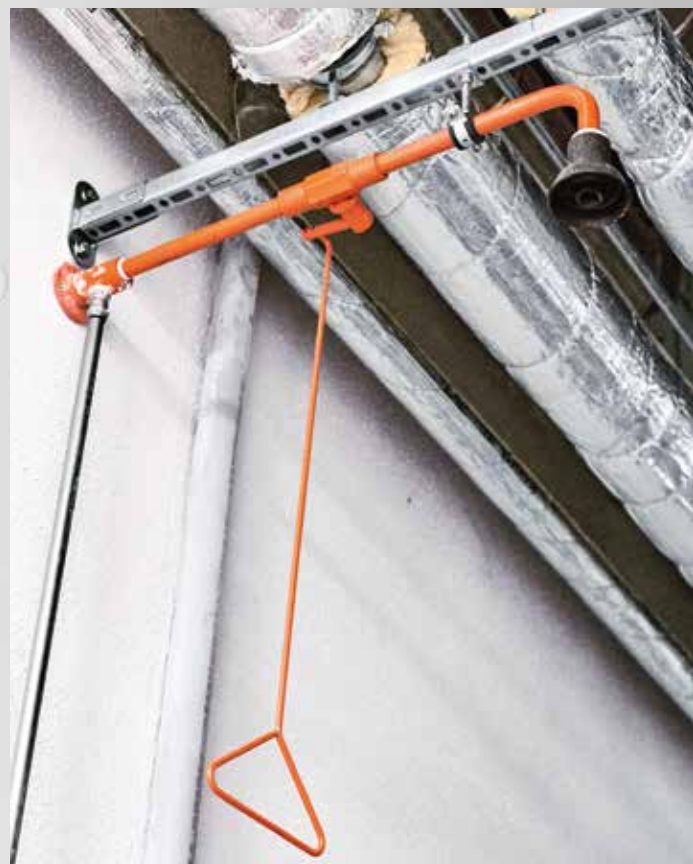
Osobní sprcha realizovaná se Sanpress Inox ve výrobě v masokombinátu Metten.
