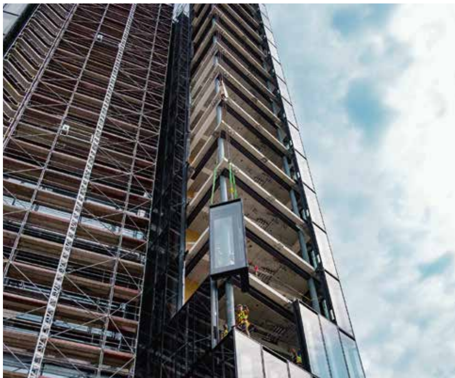
Centrála společnosti Bitzer v Sindelfingenu: až do výšky 70 m vybavená potrubními systémy pro pitnou vodu od Viega.
